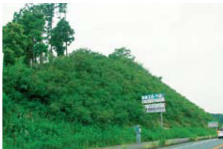
上張城西線 (TG緑化工法)
